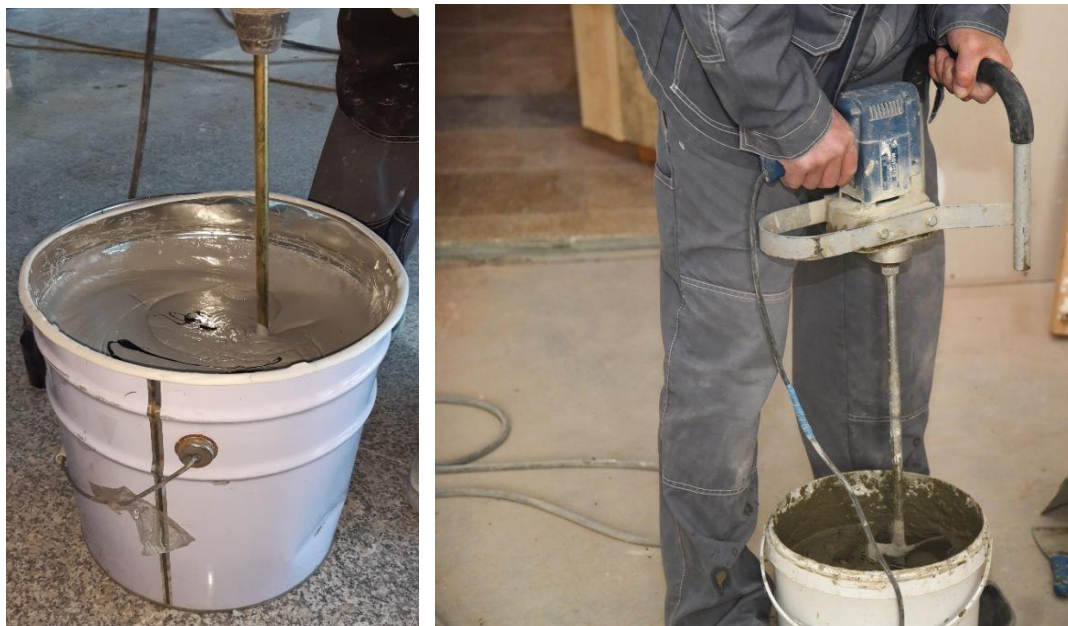
Рисунок 4 - Приготовление клеевого состава
