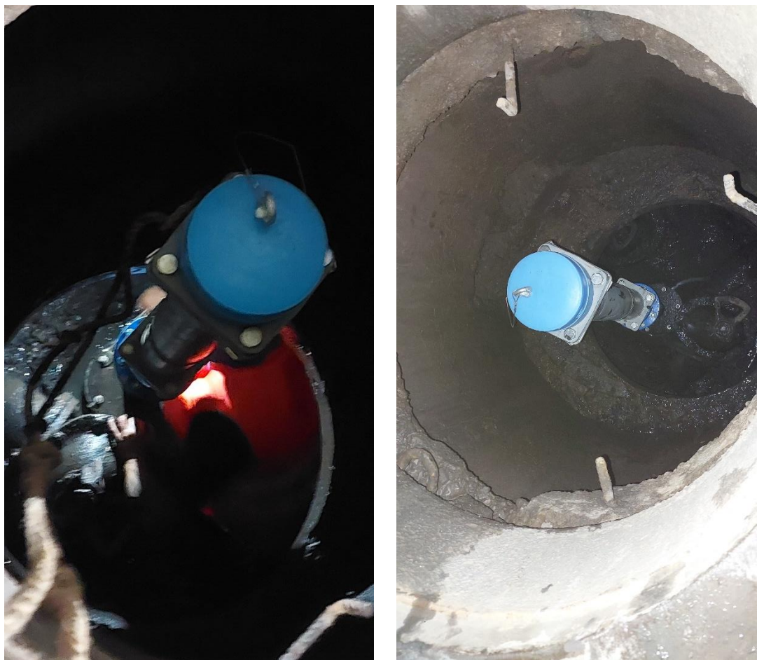
Рисунок 2 – Установка пожарного гидранта в колодце
