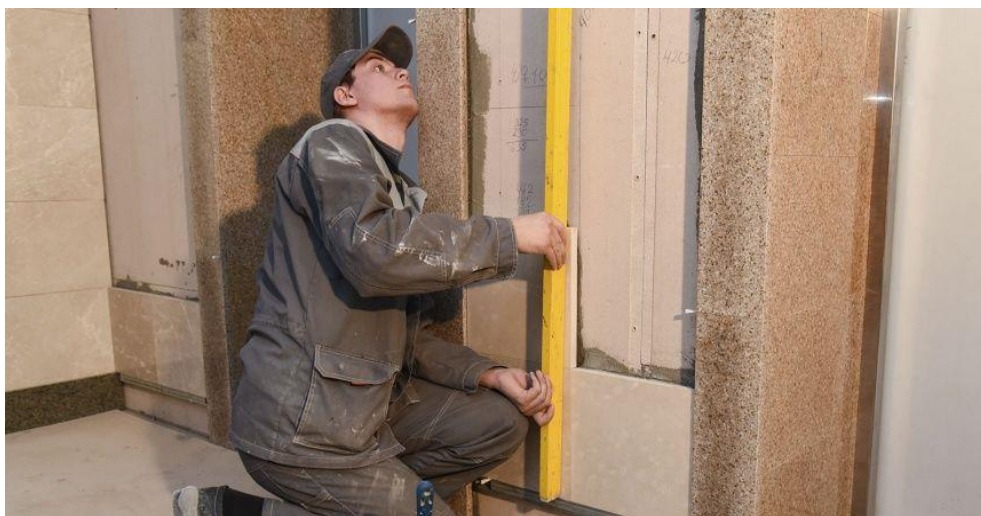
Рисунок 5 – Облицовка стен гранитными (мраморными) плитами
