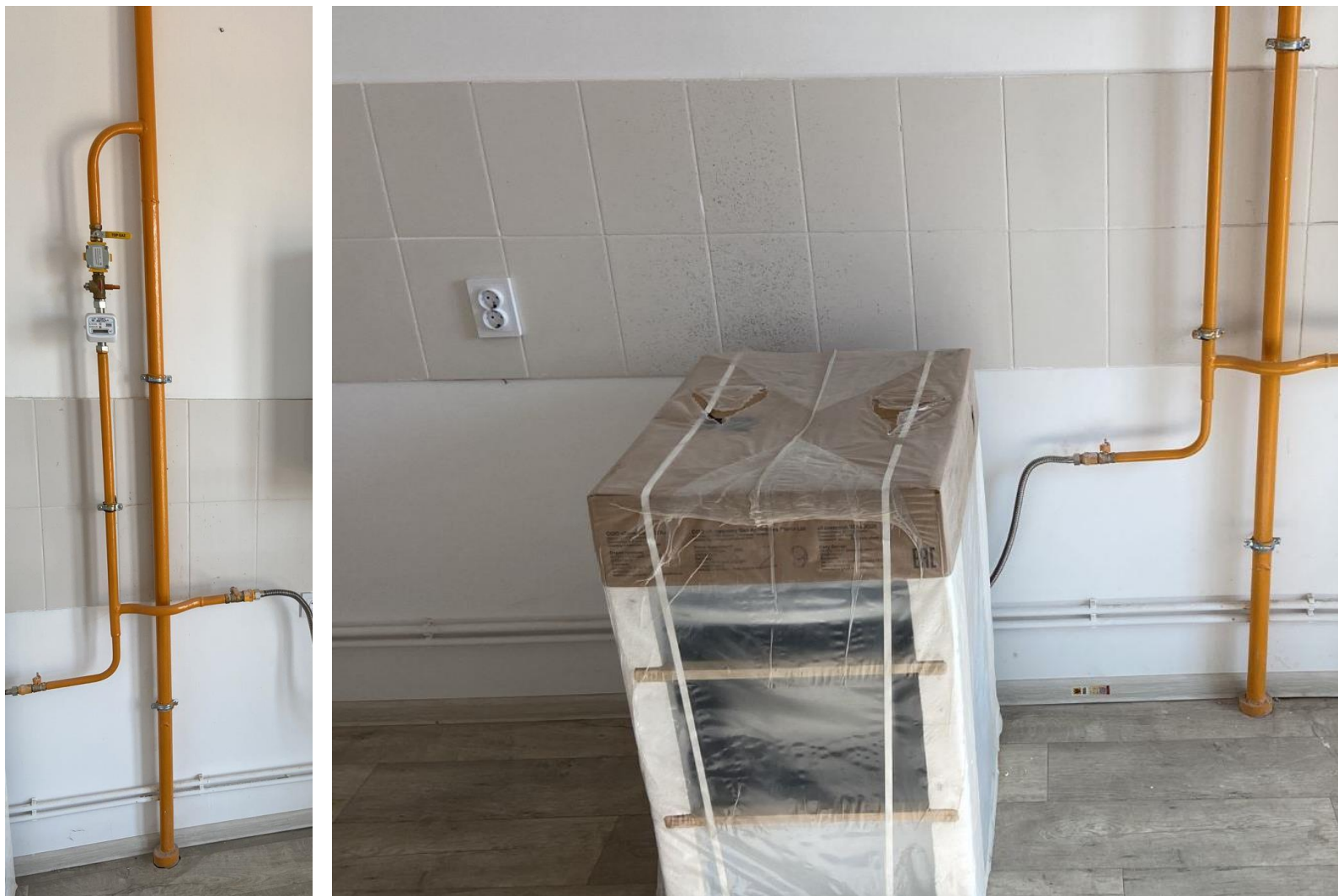
Рисунок 3 – Прокладка стальных трубопроводов
