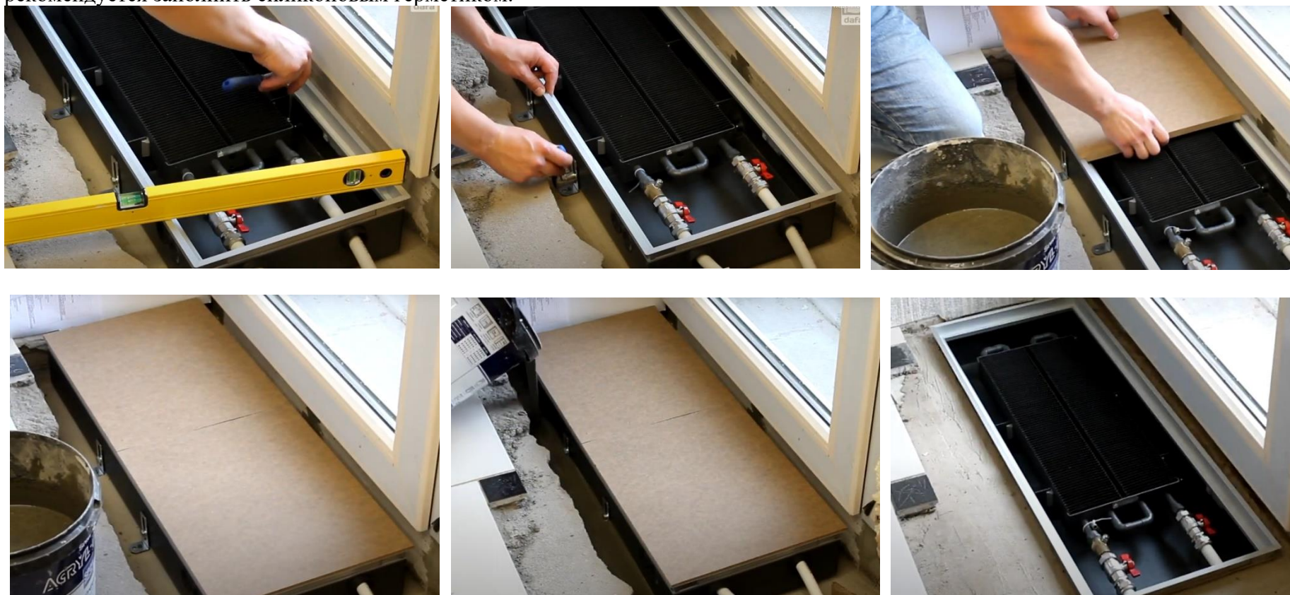
Рисунок 2.7 – Выставление уровня конвектора и заливка само нивелирующим жидким цементным раствором
